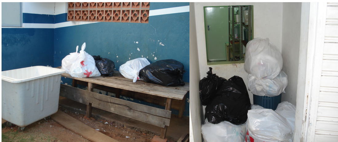
Foto 1 – Locais de armazenamento interno inadequado, em desacordo com as normas da NBR 12809.
