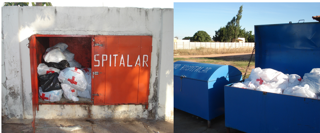
Foto 2 – Locais de armazenamento externo inadequado, em desacordo com as normas da NBR 12809.
